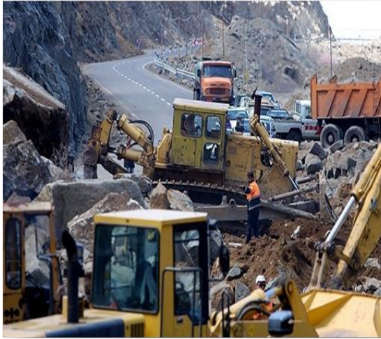
شکل ۲. پاک‌سازی جاده زنجان - تهم - طارم و رفع انسداد ناشی از سنگ ریزش مواد و روش‌ها
