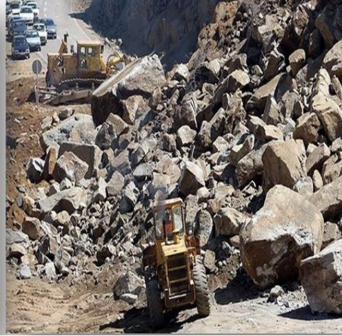
شکل ۲. پاک‌سازی جاده زنجان - تهم - طارم و رفع انسداد ناشی از سنگ ریزش مواد و روش‌ها
