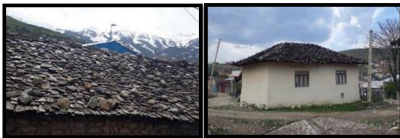
تصویر ۲. نمونه‌ای از معماری بومی ناحیه کجور (روستای نیمور) تصویر ۳. پوشش سقف با لته‌های چوب (روستای نیچکوه)
