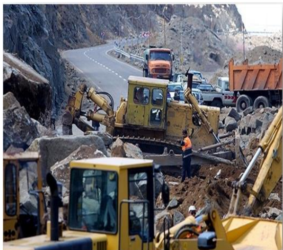
شکل ۲. پاک‌سازی جاده زنجان- تهم- طارم و رفع انسداد ناشی از سنگ ریزش مواد و روش‌ها
